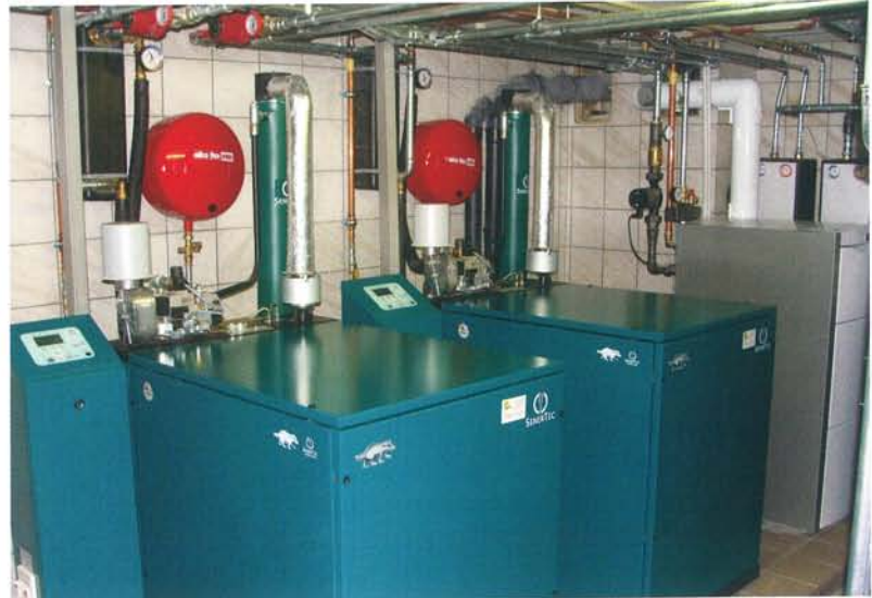
Beim Draxler Eier-Geflügel-Wild-Handel sorgt eine Dachskaskade für die Beheizung und Stromversorgung des Geschäftslokals.
