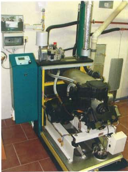
Beim Draxler Eier-Geflügel-Wild-Handel sorgt eine Dachskaskade für die Beheizung und Stromversorgung des Geschäftslokals.
