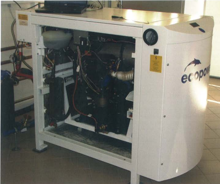
Mikro-KWK-System ecoPOWER in der HTLuVA Pinkafeld.
